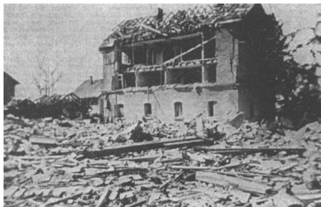
Aufnahme nach der Explosion am 25.04.1945: Völlig zerstörter Bahnhof Günzach - das Haus ist im Originalzustand im Foto oben auf der linken Seite zu sehen
