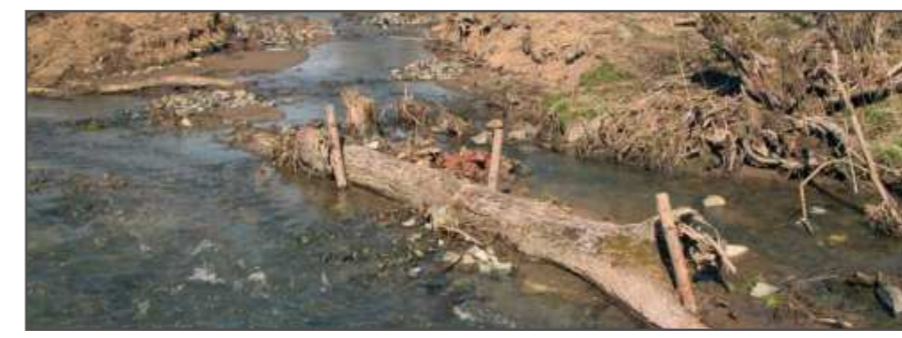
Totholz zur Sohl- und Gewässerstrukturierung
