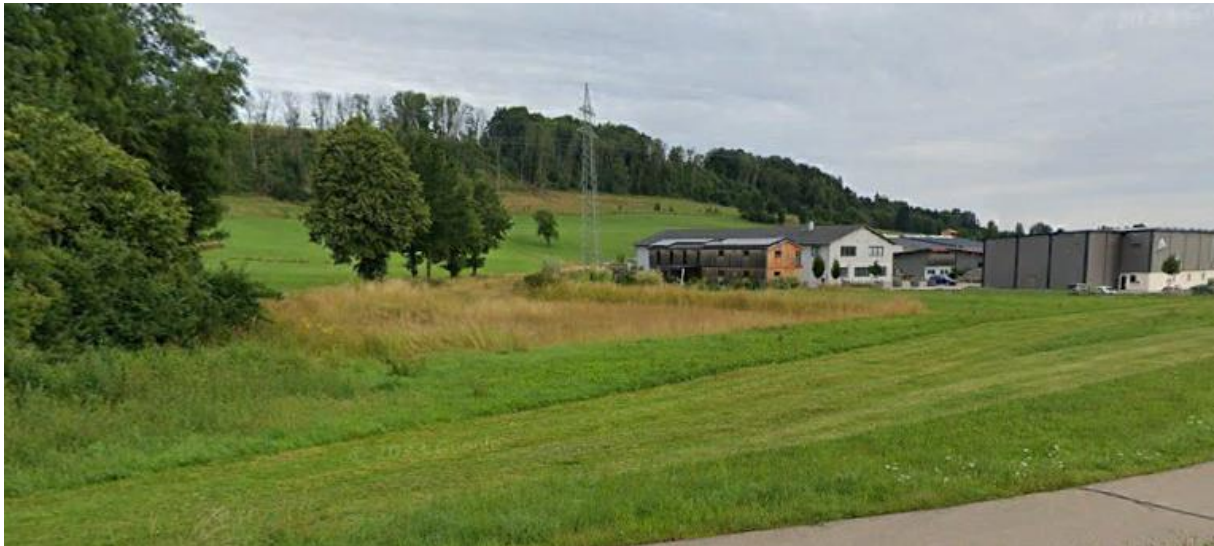
Abbildung 14: Hangneigung der geplanten PV-Fläche anhand Vor-Ort-Aufnahme
